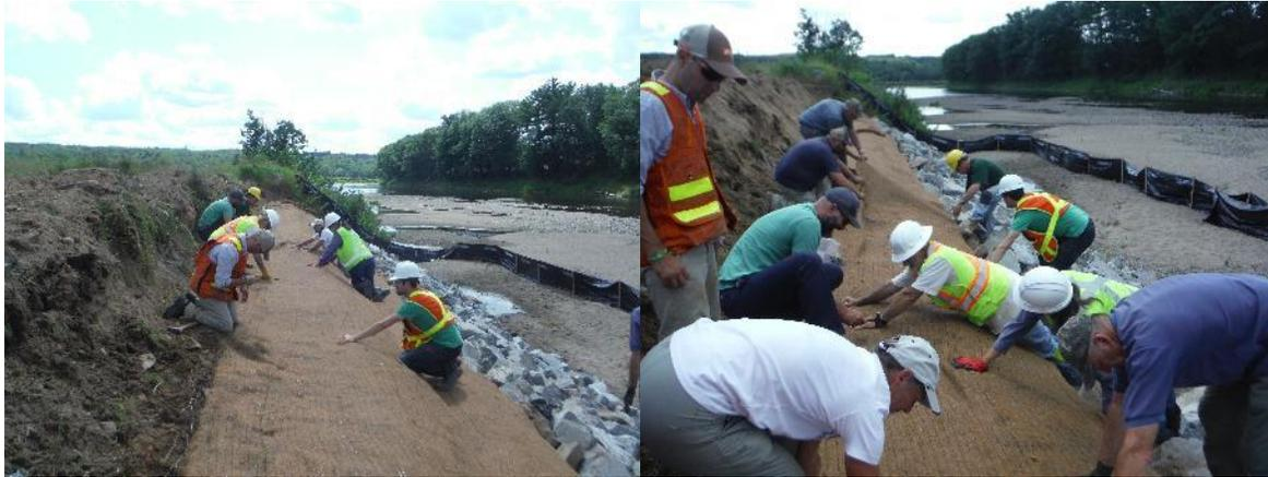
**FIGURE 7. VOLUNTEERS ASSIST WITH THE INSTALLATION OF THE C200 EROSION CONTROL BLANKETS.**
